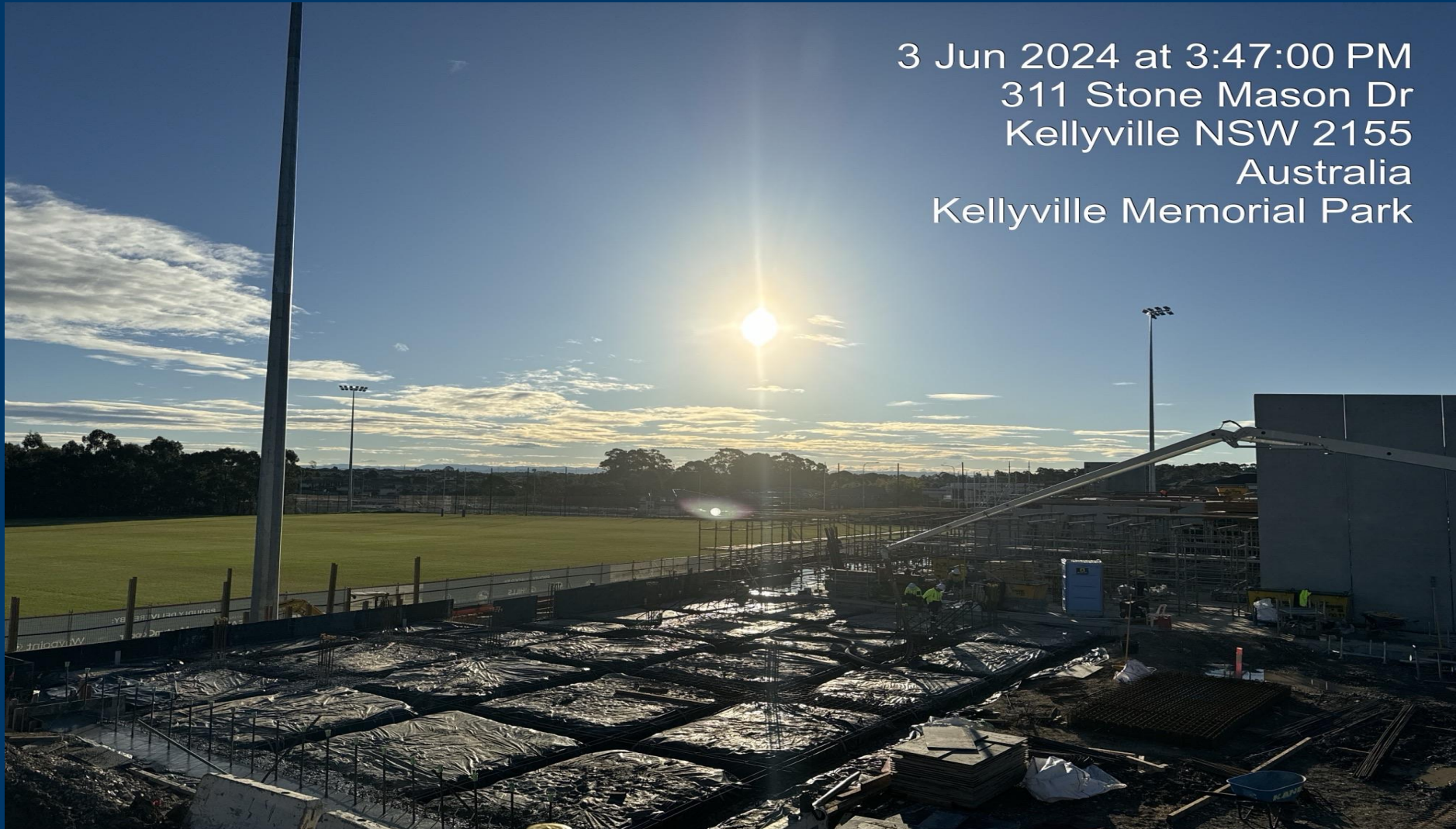
Building B – Columns and Beams Pour 4
